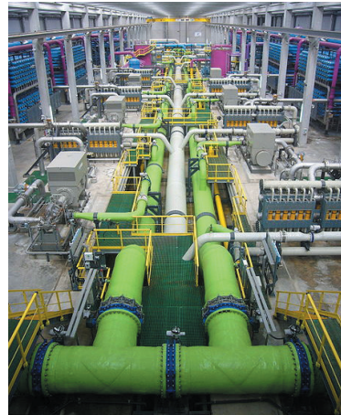
Gambar 10.24 Teknologi Osmosis Balik Skala Industri
